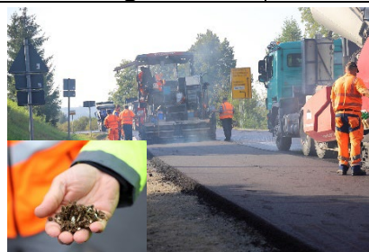
Bild: Sabine Süß – Teststrecke St 2130
