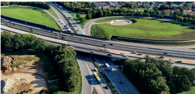
Foto: Autobahn GmbH des Bundes
